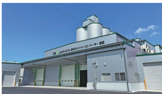
新設された胆沢カントリーエレベーター
